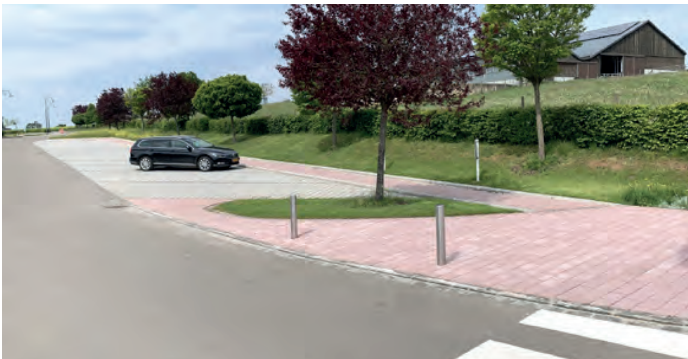
Aménagement Parking Ecole Centrale Bourscheid
