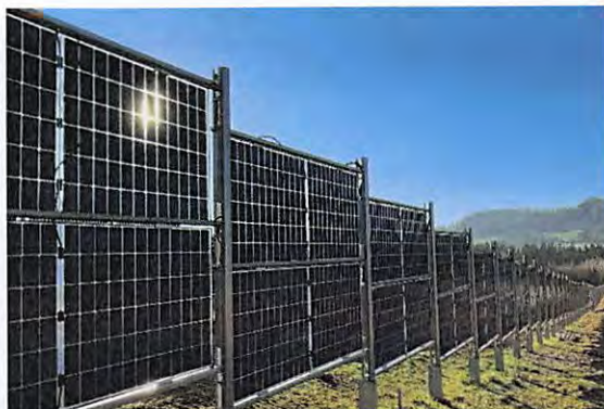
Abbildung 22: Vertikale bifaziale Module, Quelle nach [7]
